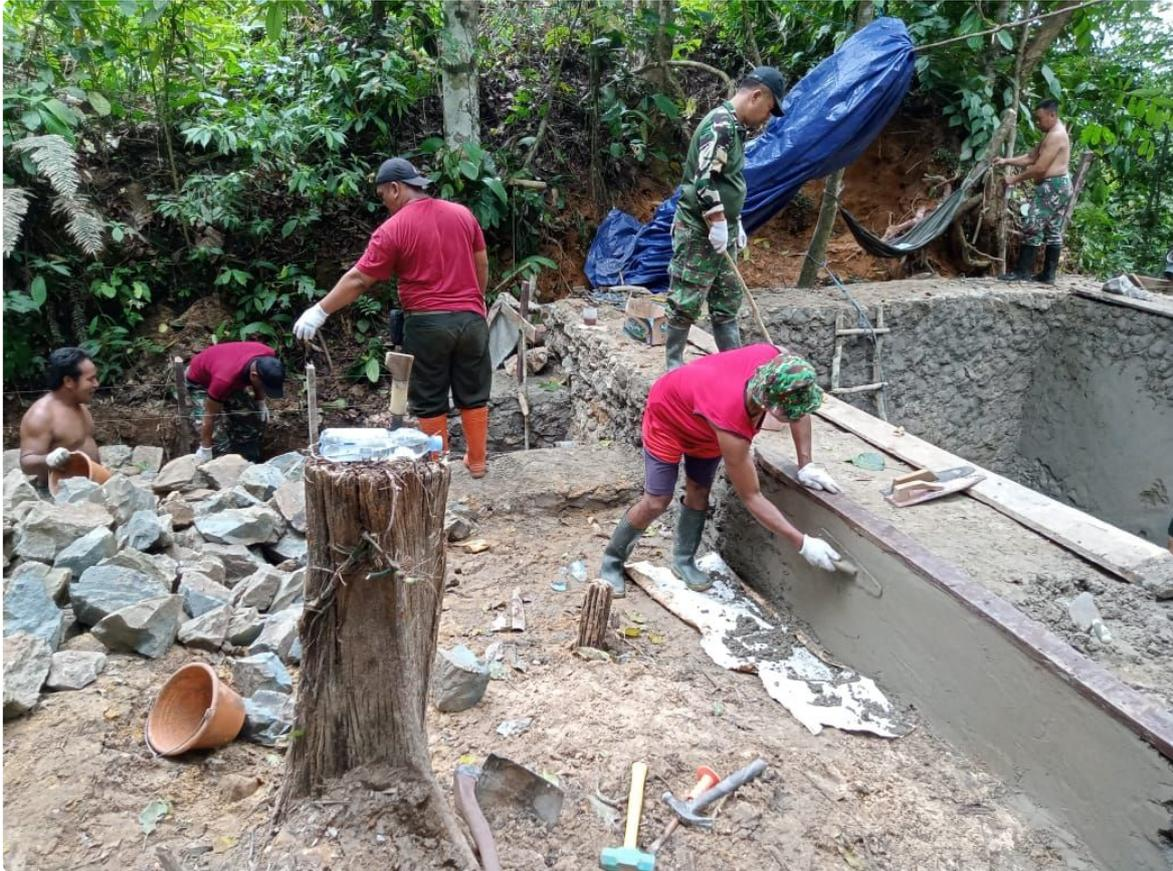
**Progres pengerjaan saat ini masih berfokus pada pembuatan pondasi parit bak air yang nantinya diharapkan bisa mengalirkan air ke bak-bak penampungan sebelum dialirkan kepemukiman warga di desa Long Anai.**
